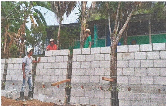
Foto 3: En proceso de trabajo de muro de contención
