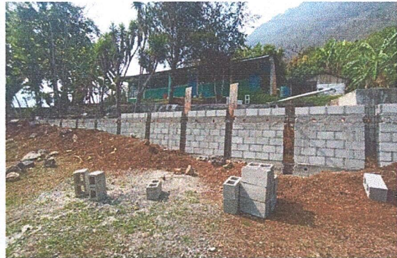
Foto 4: Remozamiento de muro de contención
