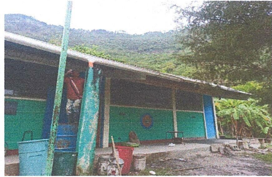
Foto 2: En proceso de trabajo de bajada de canales plubiales
