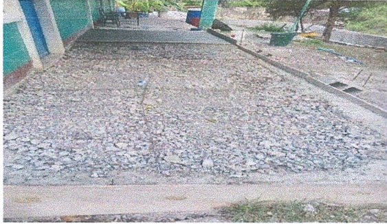
Foto 1: En proceso de trabajo de piso
